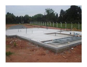
**Radier:** Semelhante a uma placa que abrange toda a área da construção, recebendo toda a carga e distribuindo-a no terreno.
