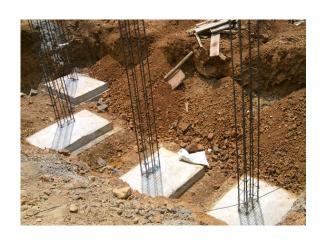
Sapata: elemento de concreto armado, geralmente quadrada, retangular ou trapezoidal, dimensionado de modo que as tensões nele produzidas sejam resistidas pela armadura, não pelo concreto. A sapata corrida recebe a carga distribuída linearmente
