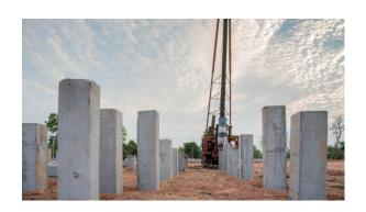
**Estacas:** Elemento executado inteiramente por equipamentos ou ferramentas, sem que, em qualquer fase de sua execução, haja descida de operário. As estacas têm grandes comprimentos e seções transversais pequenas, podem ser de madeira, aço, concreto pré-moldado, concreto moldado *in loco* ou mistos.
