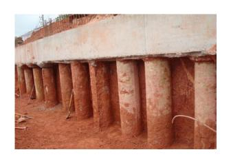
**Tubulões:** Elemento de fundação profunda, cilíndrico, em que, pelo menos na sua etapa final, há descida de operário. Pode ser feito a céu aberto ou sob ar comprimido (pneumático) e ter ou não base alargada. Pode ser de aço ou concreto, com ou sem revestimento.
