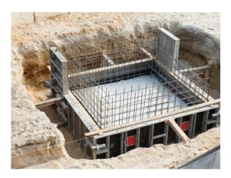
**Caixões**: Elemento de forma prismática, concretado na superfície e instalado por escavação interna, podendo usar ar comprimido; sua base pode ser alargada ou não.
